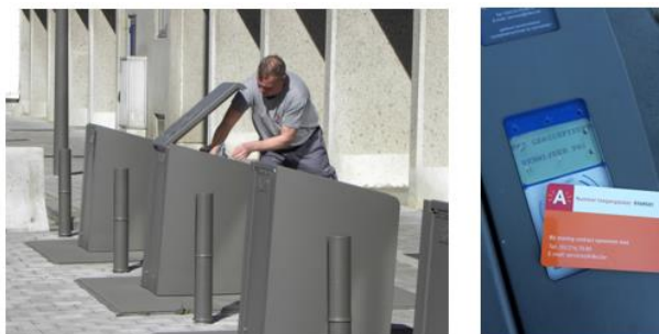
Εικόνα 16: Πρόγραμμα ΠΟΠ με μέτρηση όγκου των απορριπτόμενων αποβλήτων μέσω κατάλληλων αισθητήρων
