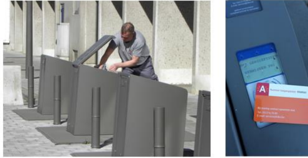
Εικόνα 29: Πρόγραμμα ΠΟΠ με μέτρηση όγκου των απορριπτόμενων αποβλήτων μέσω κατάλληλων αισθητήρων
